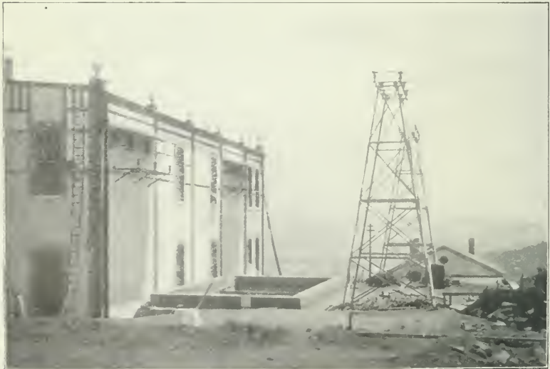
FIG. 2.—SUB-STATION AT EL ORO.
